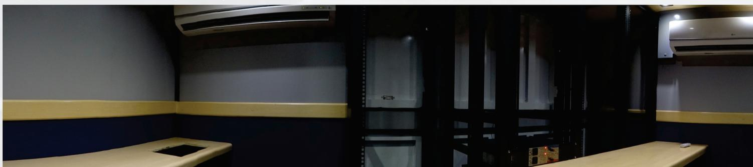
Em um baú de pequenas dimensões (4,65 x 2,2 metros) há espaço para oito profissionais, com quatro colunas de rack totalizando 170 Urs, sendo 149 Urs disponíveis para a instalação de equipamentos
